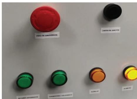
**H** Si hay una falla en la moto válvula, el indicador ámbar derecho encenderá
