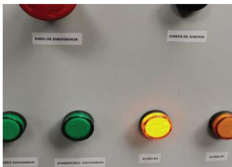
**G** Si hay una falla en motor de transmisión, el indicador ámbar izquierdo encenderá.
