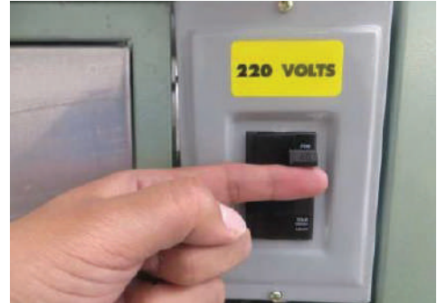
2 Accionar interruptor de 1 polo 30 amperes.
