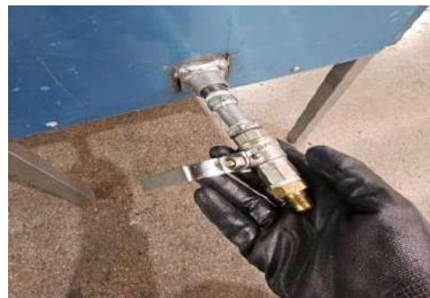
**2** Conectar llave de paso y niple terminal a freidor
